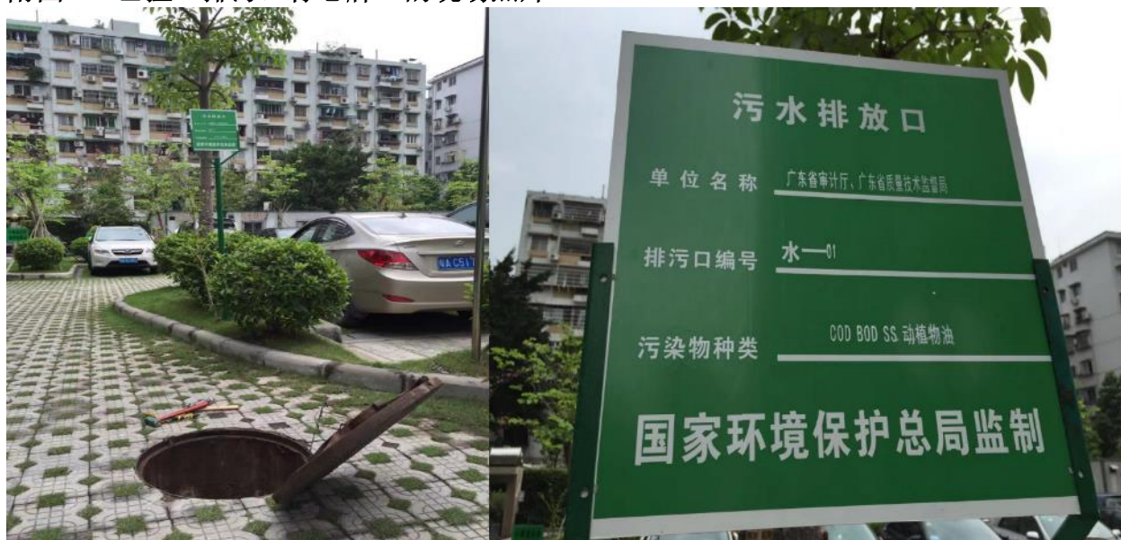
水-01 排放口现场（废水总排放口）
