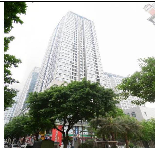
东面 中铁置业大厦
