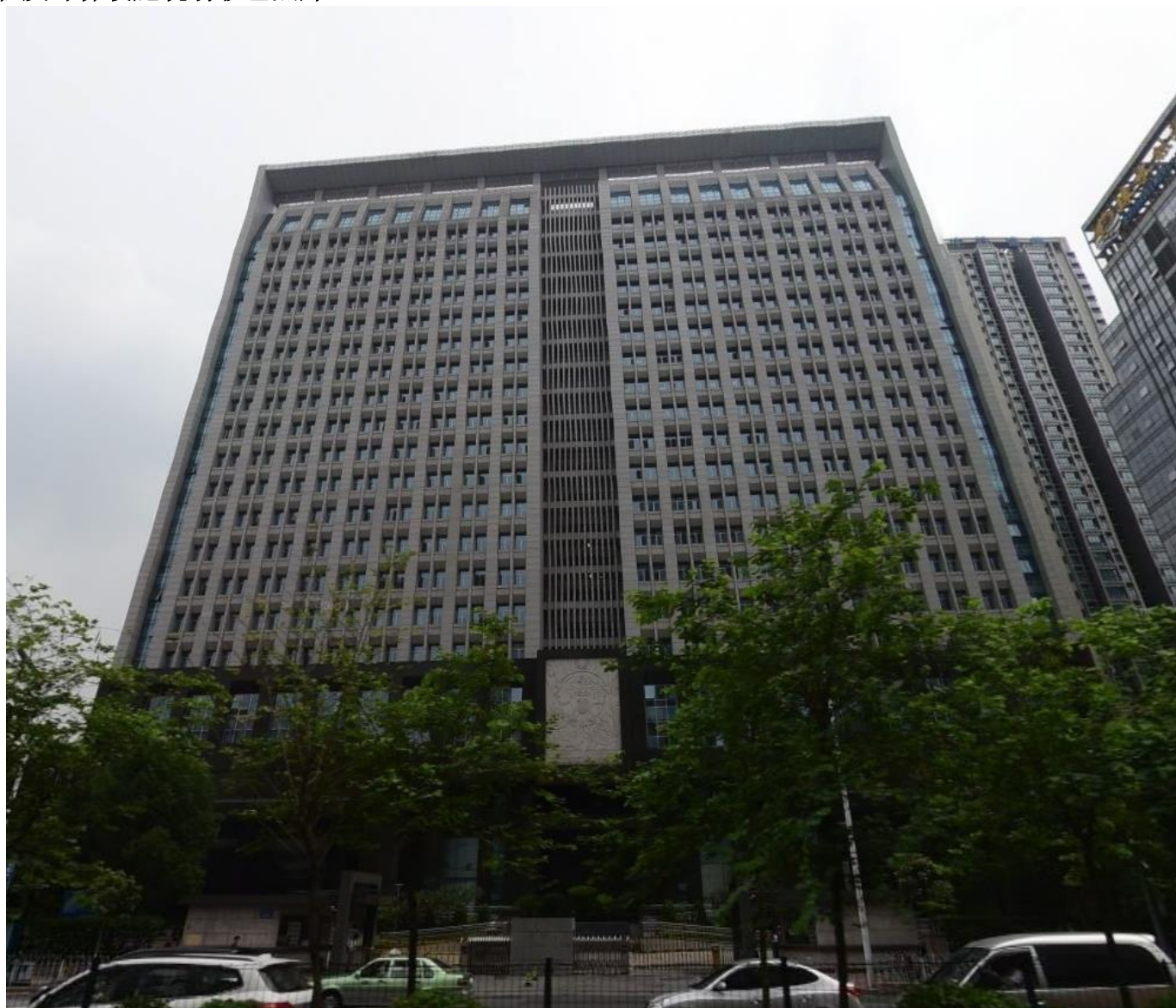
主体工程照片（广东省审计厅、广东省质监局办公楼主楼）
