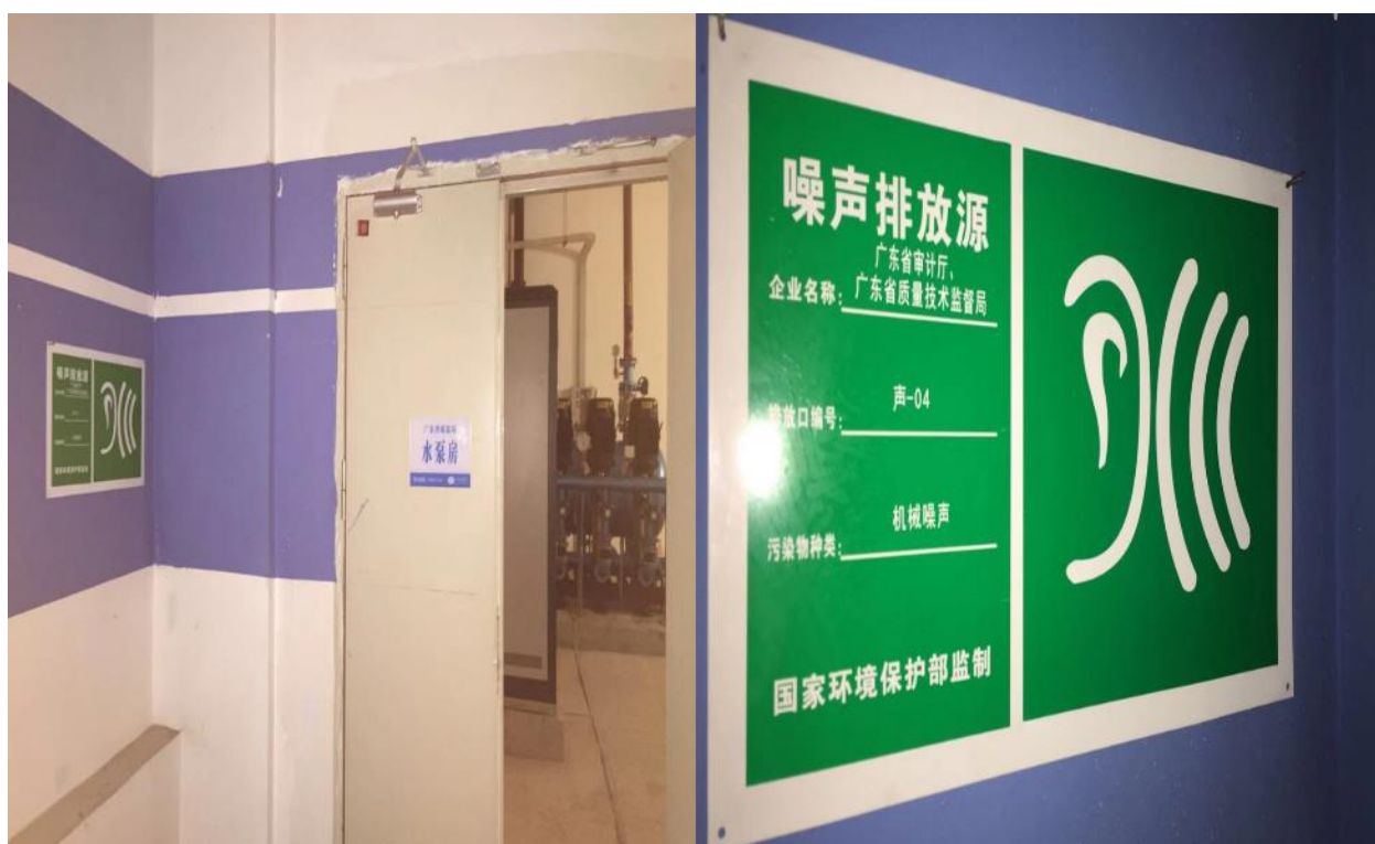
声-04 排放口现场（水泵房 2#）
