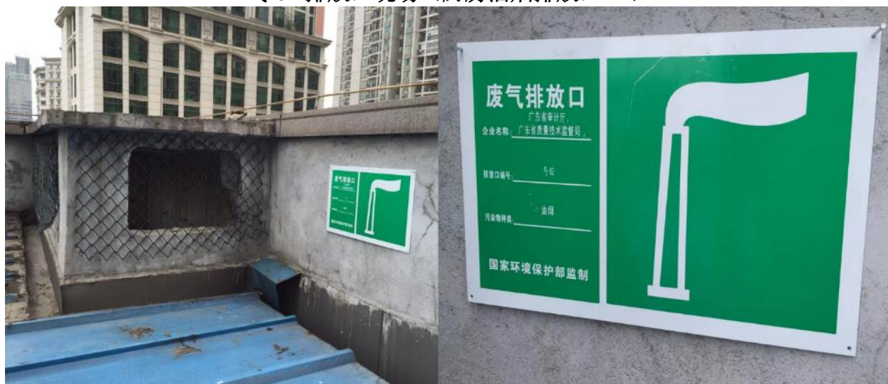
气-02 排放口现场（厨房油烟排放口 2#）
